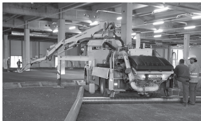
Bild 6. Betonpumpe mit Absaugung in einer Halle.
