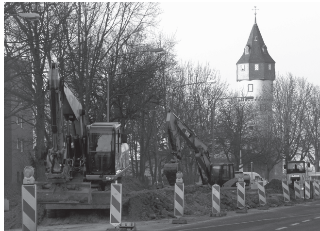
Bild 1. Baumaschinen im Einsatz.
